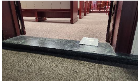
圖七、憲法法庭入口設有門檻，此高低差可能造成輪椅進入障礙。
