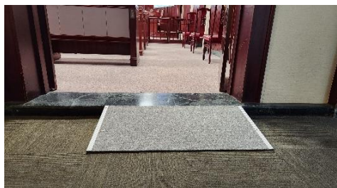
圖八、憲法法庭於 109 年起購置移動式斜坡備用，並採活動式設計，於無需求時即拆卸收納。
